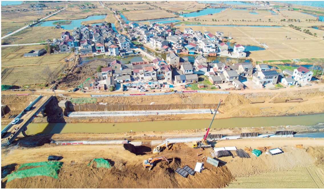
在丹徒区景家渡桥标段,施工现场一片繁忙景象。
